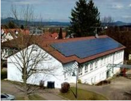
Fotovoltaik auf der Grundschule
